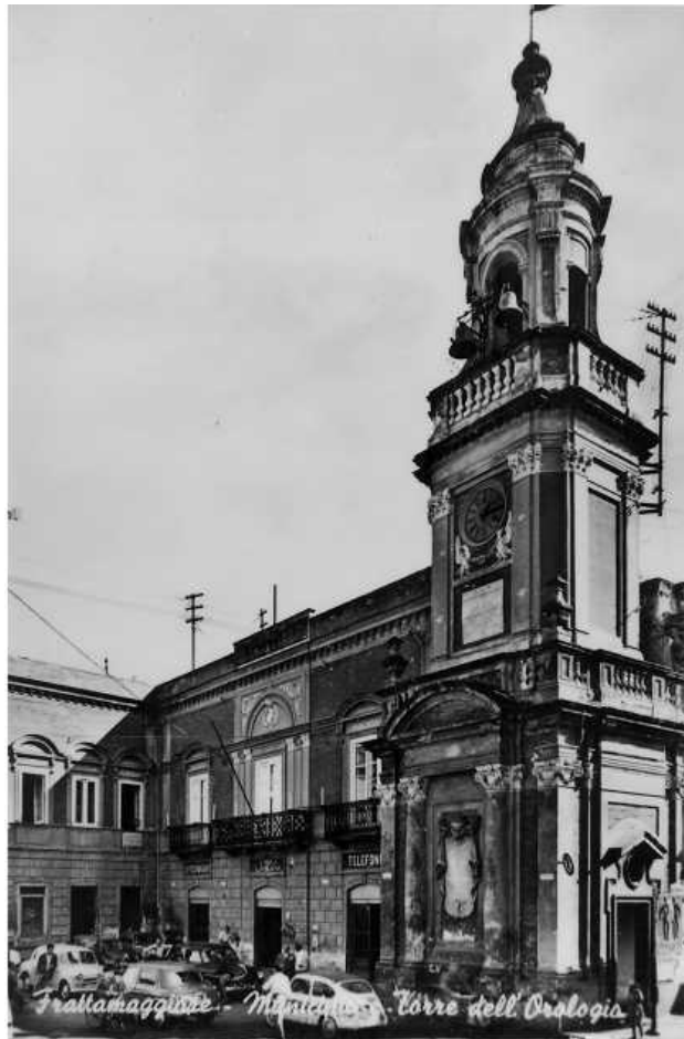
Municipio - Torre dell'Orologio - G. Alborino, Frattamaggiore.
