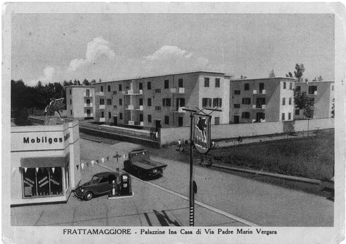
Palazzine Ina Casa di Via Padre Mario Vergara, Frattamaggiore.
