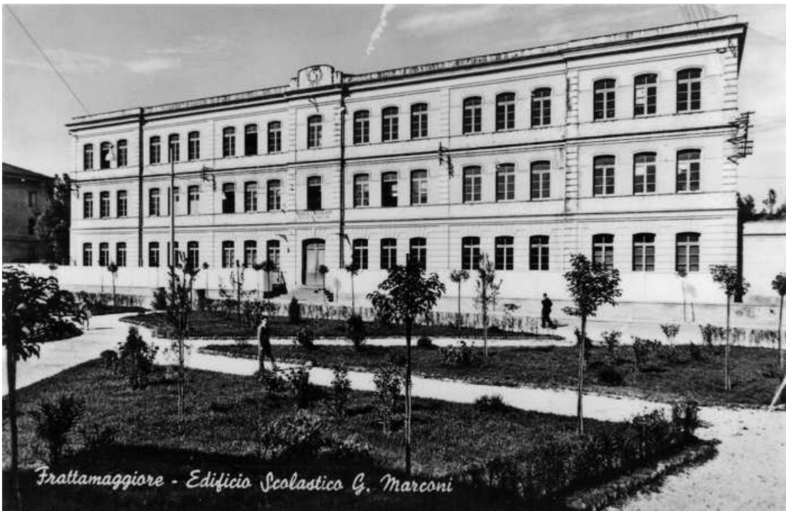
Edificio Scolastico G. Marconi - G. Alborino, Frattamaggiore.
