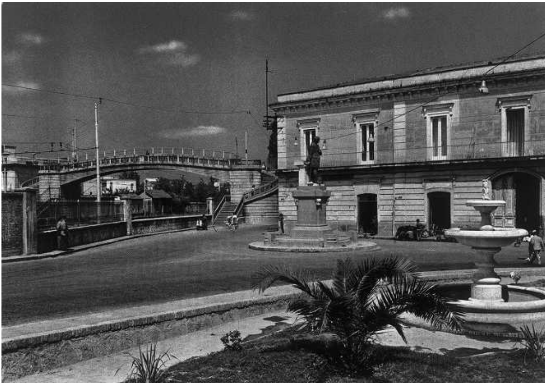
Ponte pedonale - G. Alborino, Frattamaggiore.
