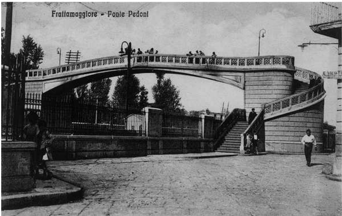
Ponte pedoni - G. Farina, Frattamaggiore.
