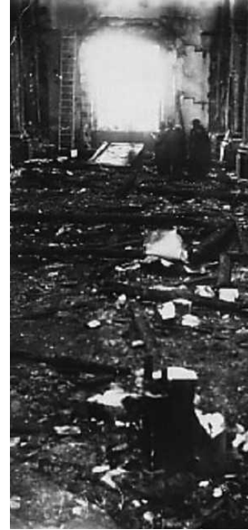
La navata centrale della chiesa di San Sossio dopo l'incendio del 29 novembre 1946.
