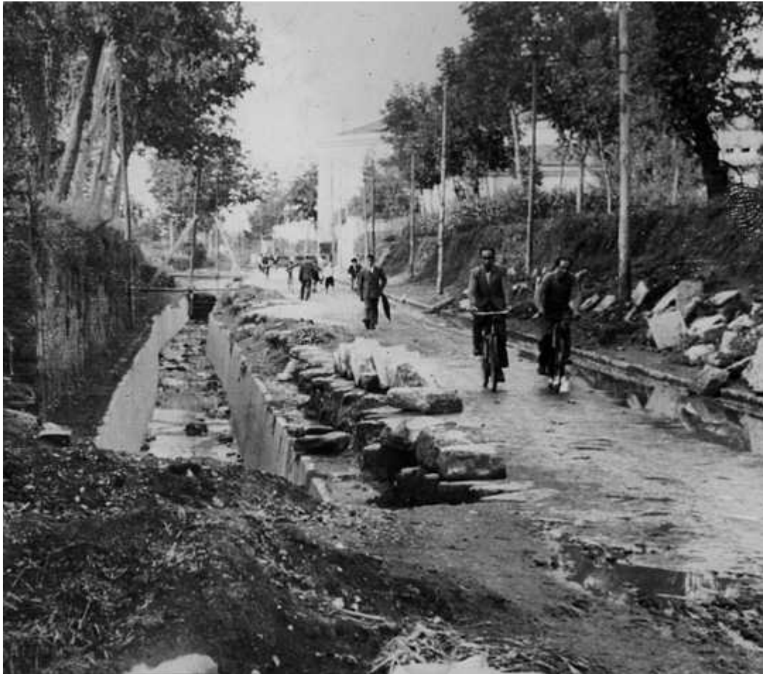
Via Domenico Pirozzi durante i lavori di pavimentazione.
