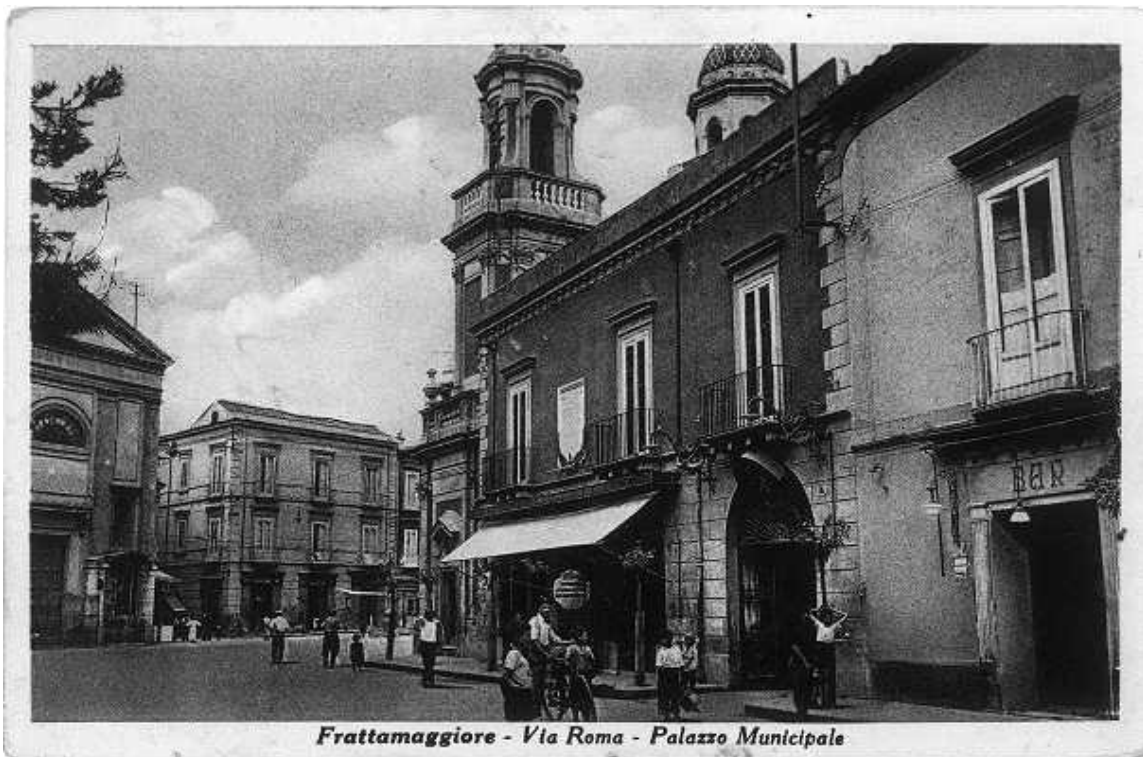
Frattamaggiore - Via Roma - Palazzo Municipale Via Roma - Palazzo Municipale, Frattamaggiore.
