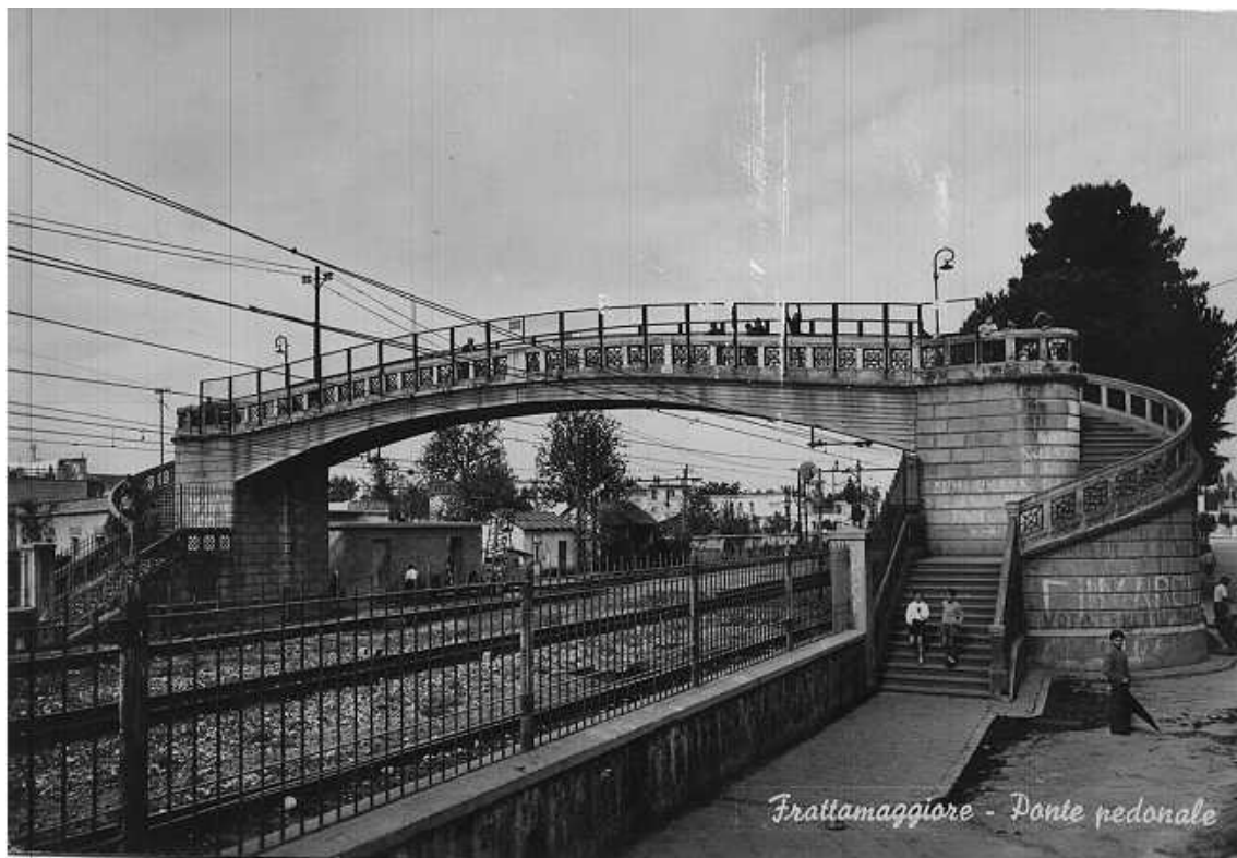
Ponte pedonale - G. Alborino, Frattamaggiore.
