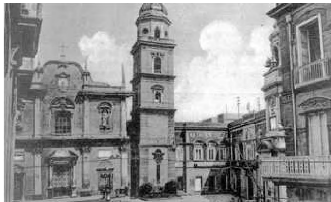
Fig. 17 - La facciata dell'abbattuta Casa Comunale in una foto d'epoca
