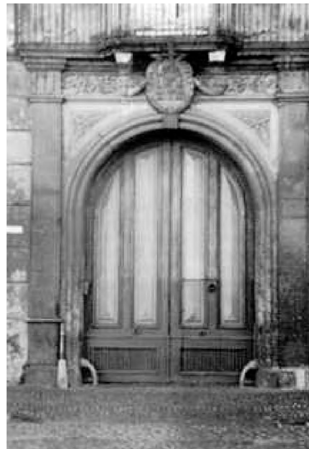
Fig. 20 - Il portale di palazzo Lupoli a Frattamaggiore
